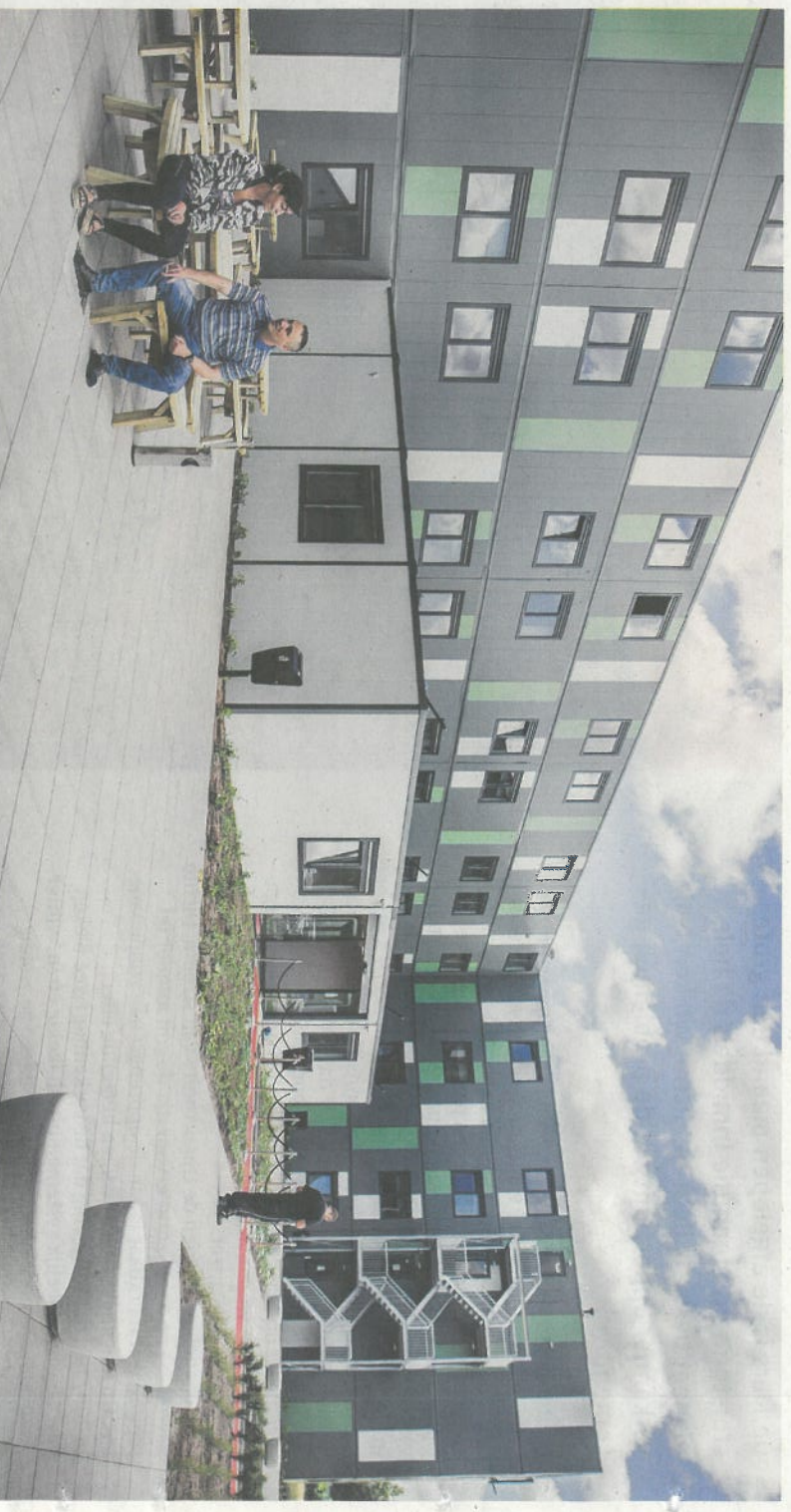
Het wooncomplex voor vierhonderd arbeidsmigranten op een bedrijventerrein aan de rand van Waalwijk.
